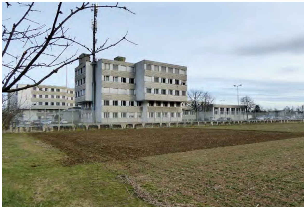
Zur Anpflanzung vorbereitetes Feld mitten in Wetzelsdorf, neben der Landespolizeidirektion Steiermark und einer Wohnsiedlung Field prepared for planting in the middle of Wetzelsdorf, next to the Styrian police headquarters and a housing estate
