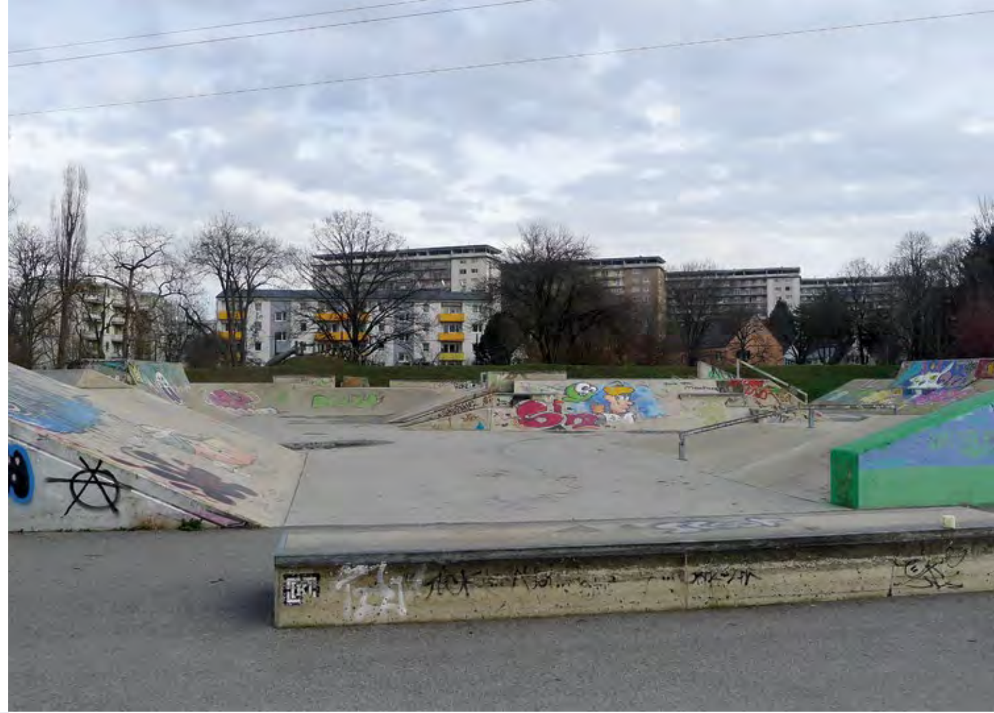
Am Grünanger: Skatepark mit Blick auf die Wohnbebauung Kasernstraße Am Grünanger: skate park with view of housing estate in Kasernstrasse
